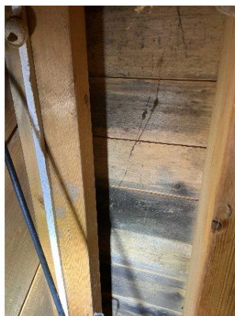
Bild 2: - Utvändigt, Vind, Huset är självdragsventilerat, se riskanalysen Mikrobiell påväxt noterades på del av underlagstak...
