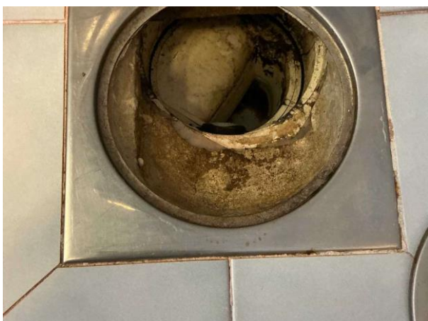
Bild 5: - Invändigt, Souterrängplan, Äldre våtrum se riskanalysen. Golvbrunnen är väggnära monterad. Kaklad ovan plastmatta. Golvbrunn ej...
