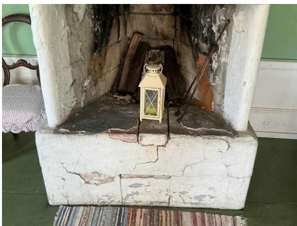
Bild 13: - Invändigt, Entréplan, Sprickor i öppenspisen Golvet lutar
