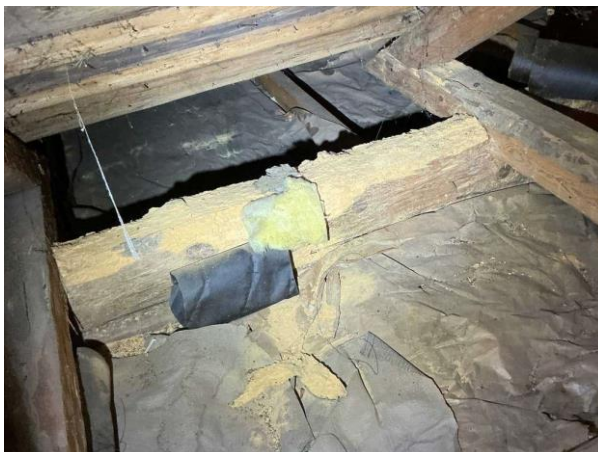
Bild 2: - Utvändigt, Vind, Huset är självdragsventilerat, se riskanalysen Spår av träskadeinsekter noterades på takbjälkar o...
