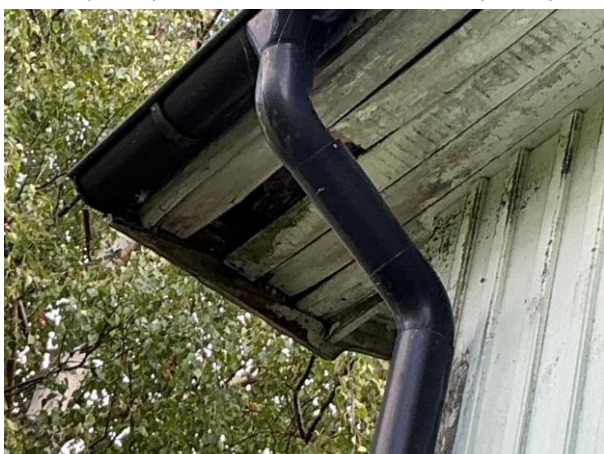
Bild 5: - Utvändigt, Yttertak, Äldre tak se riskanalysen Rötskador i takfoten Vindskivor har rötskador Tegelpannor ovan äldre ...
