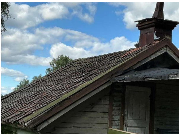
Bild 10: - Utvändigt, Yttertak, Taket är i direkt behov av omläggning då det läcker in Det ligger plåttak under tegelpannorna Ro...
