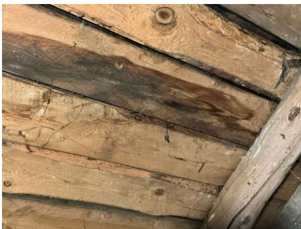
Bild 4: - Utvändigt, Vind, Huset är självdragsventilerat, se riskanalysen Spår av träskadeinsekter noterades på takbjälkar o...
