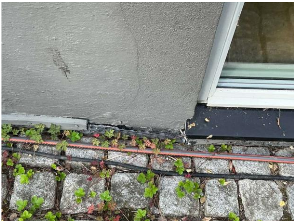
Bild 1: - Utvändigt, Grundmur/Hussockel, Platonmatta uppdragen ovan mark (skall vara övertäckt med jord/grus) Topplist saknas lokalt på Pl...
