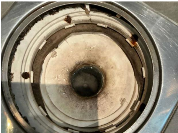
Bild 5: - Invändigt, Entréplan, Renoverat 2005 Avlopp under handfat ej uppdraget ovan golv Rost på skruvar till klämring (fel S...
