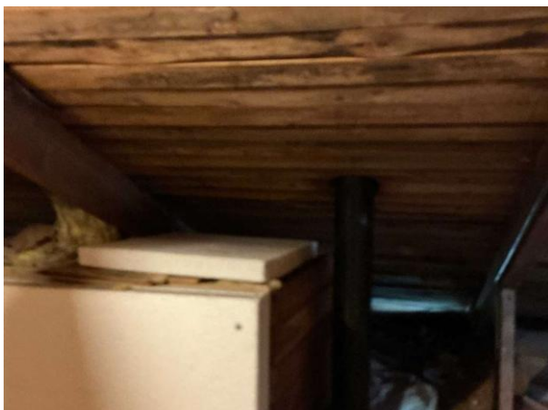
Bild 5: - Utvändigt, Vind, Huset är självdragsventilerat Lokalt noteras det mikrobiell påväxt samt fuktrosor.
