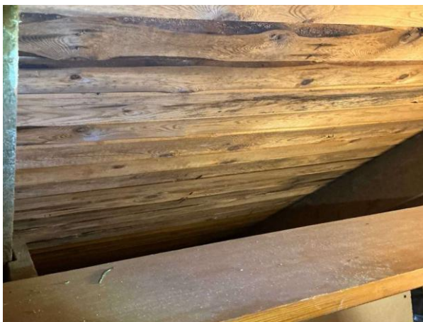
Bild 4: - Utvändigt, Vind, Huset är självdragsventilerat Lokalt noteras det mikrobiell påväxt samt fuktrosor.
