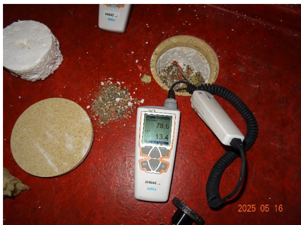
Bild 1: Fuktmätning i golv, förråd i källaren
