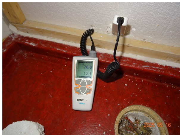
Bild 2: Fuktmätning i vägg, förråd
