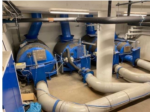
Sopor och bioavfall slängs ner i de blå rören – landar i sugkärlet och sugs ut till bilen
