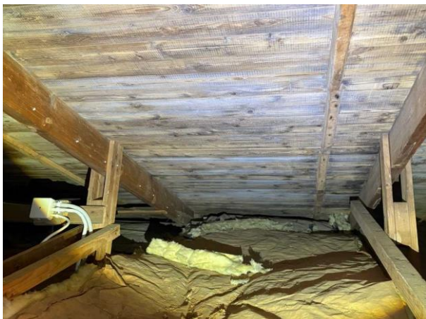
Bild 1: - Utvändigt, Vind, Huset är självdragsventilerat Mikrobiell påväxt noterades på underlagstaket (se säljupplysningar)...
