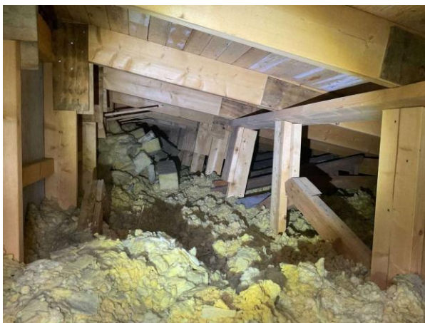
Bild 4: - Utvändigt, Vind, Huset är självdragsventilerat, Vinden är tilläggsisolerad vinden är besiktigad från luckan
