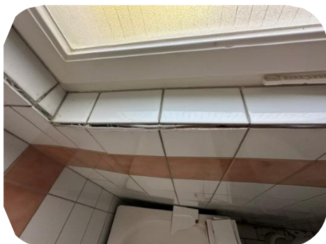
Det noterades att kakelplattor har börjat släppa från flertalet väggar runtom i badrummet, normala fuktindikationer noterades på väggarna vid besiktningstillfället.
