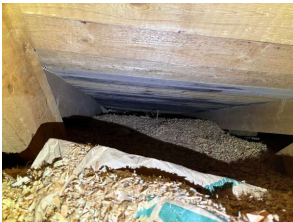
Bild 2: Utvändigt, Vind, Huset är självdragsventilerat, se riskanalysen Parallellisolerade /snedtak Spånet (isoleringen) ligger inte utlagt på hela vinden Lokalt not...
