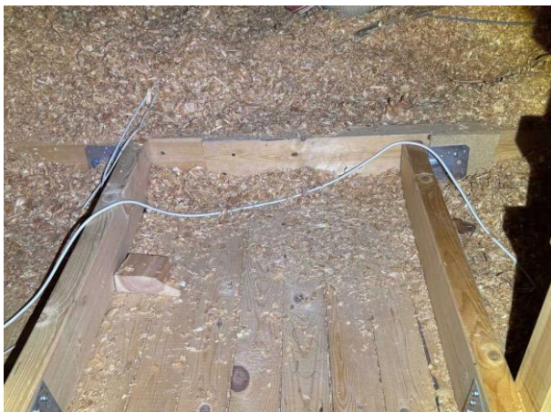
Bild 1: Utvändigt, Vind, Huset är självdragsventilerat, se riskanalysen Parallellisolerade /snedtak Spånet (isoleringen) ligger inte utlagt på hela vinden Lokalt not...
