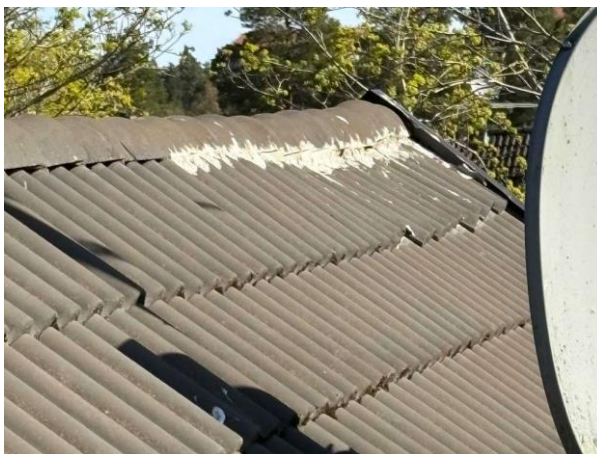
Bild 4: Utvändigt, Yttertak, Tätning med bruk motnocken
