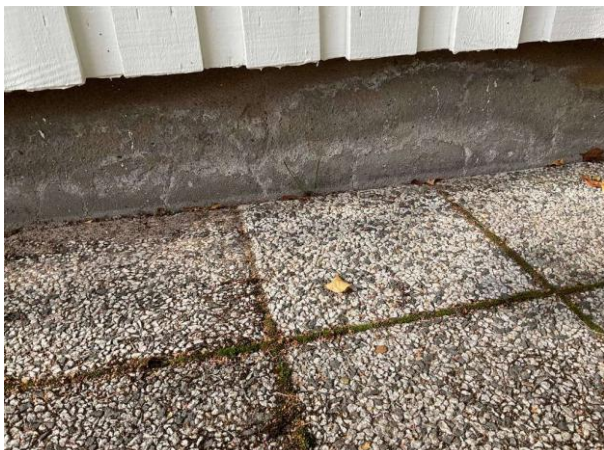
Bild 1: - Utvändigt, Grundmur/Hussockel, Delvis dold av altanen Mindre sprickor noteras på hussockeln
