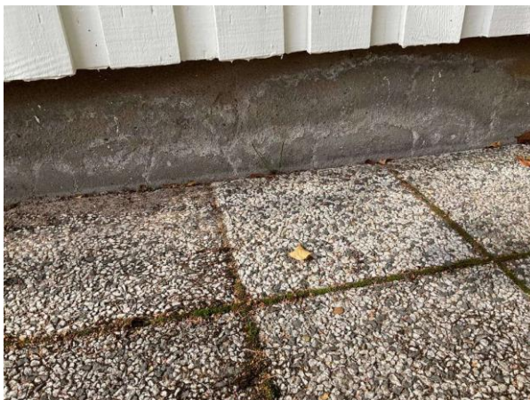
Bild 2: - Utvändigt, Grundmur/Hussockel, Delvis dold av altanen Mindre sprickor noteras på hussockeln
