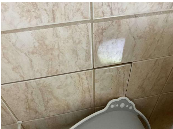
Bild 5: - Invändigt, Entréplan, Spricka noteras på kakel
