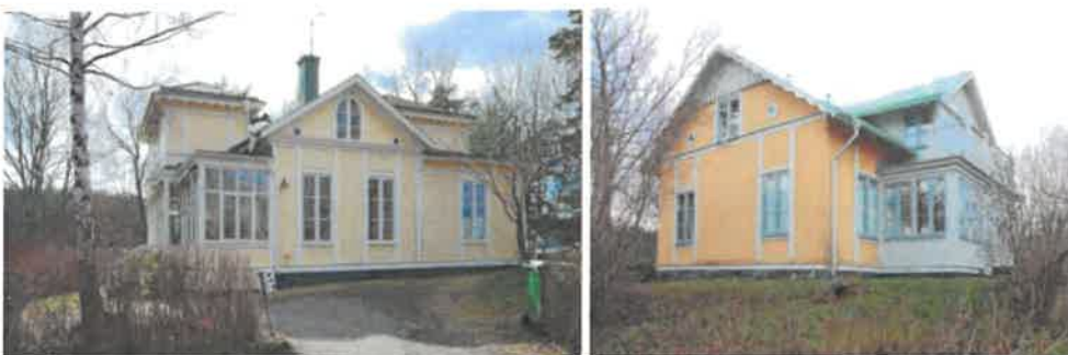
Björkholmen (vänster) är en ståtligt utformad sommarvilla i ljus panelarkitektur som är välbevarad sedan ca 1865. Björkudden (höger) från 1876 är en välbevarad före detta sommarvillorna från 1860-1870-talet vid Ekholmsnäs.
