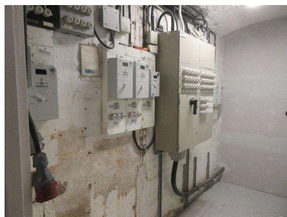
Moderniserade elektriska installationer
