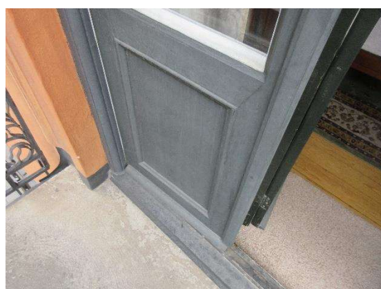
Dörrar och fönster i relativt gott skick
